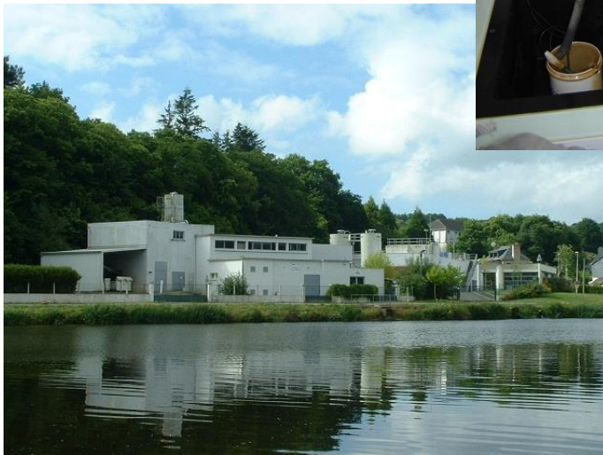
Usine de traitement des eaux de Langroise à Hennebont (56)
